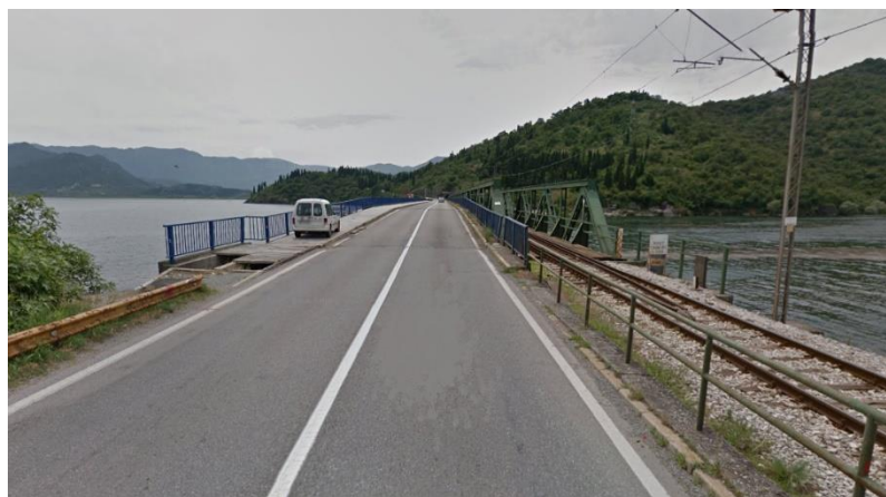
Slika br.1.10. Željezničko – drumski most preko Skadarskog jezera
